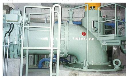
放流ゲート ポンプで排水した雨水と、遊水地の雨水を放流します。
