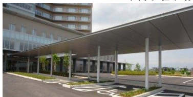
駐車場からの通路
