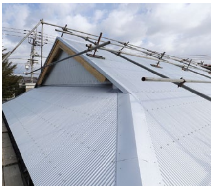
▲ ガルバリウム鋼板設置の様子
