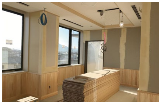
▲ 内装施工状況(3階議会スペース)
