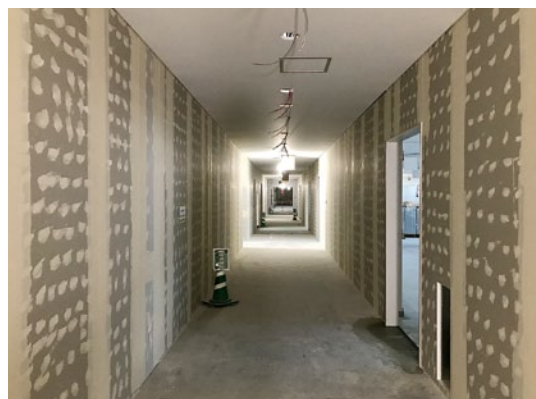
▲ 2階壁・天井施工状況
