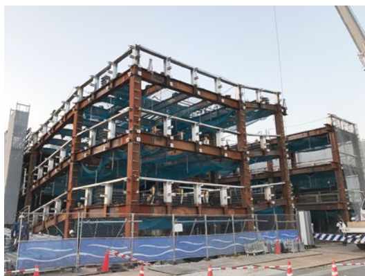
▲ 立体駐車場鉄骨建方状況
