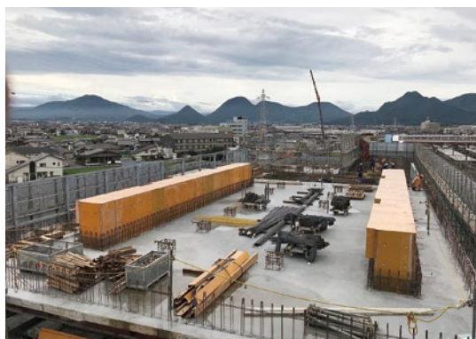
▲ 庁舎棟屋上躯体施工状況
