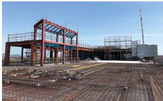
▲ ホール棟屋上駐車場床施工状況
