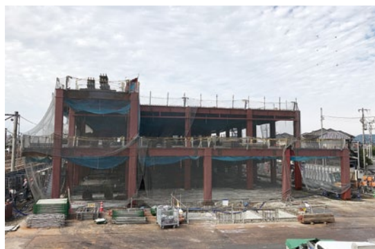
▲ 庁舎・ホール棟鉄骨建方完了状況
