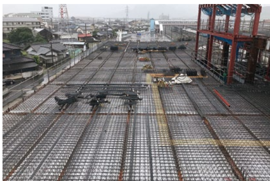
▲ ホール棟屋上床施工状況
