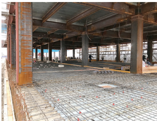
▲ 庁舎棟1階床施工状況
