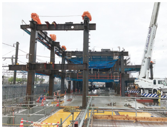
▲ 庁舎棟鉄骨工事施工状況
