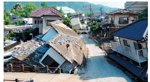
▲平成28年4月に発生した熊本地震の被害の様子
