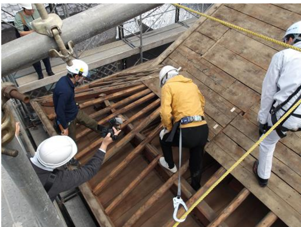
屋根部野地板除去及び調査状況②
