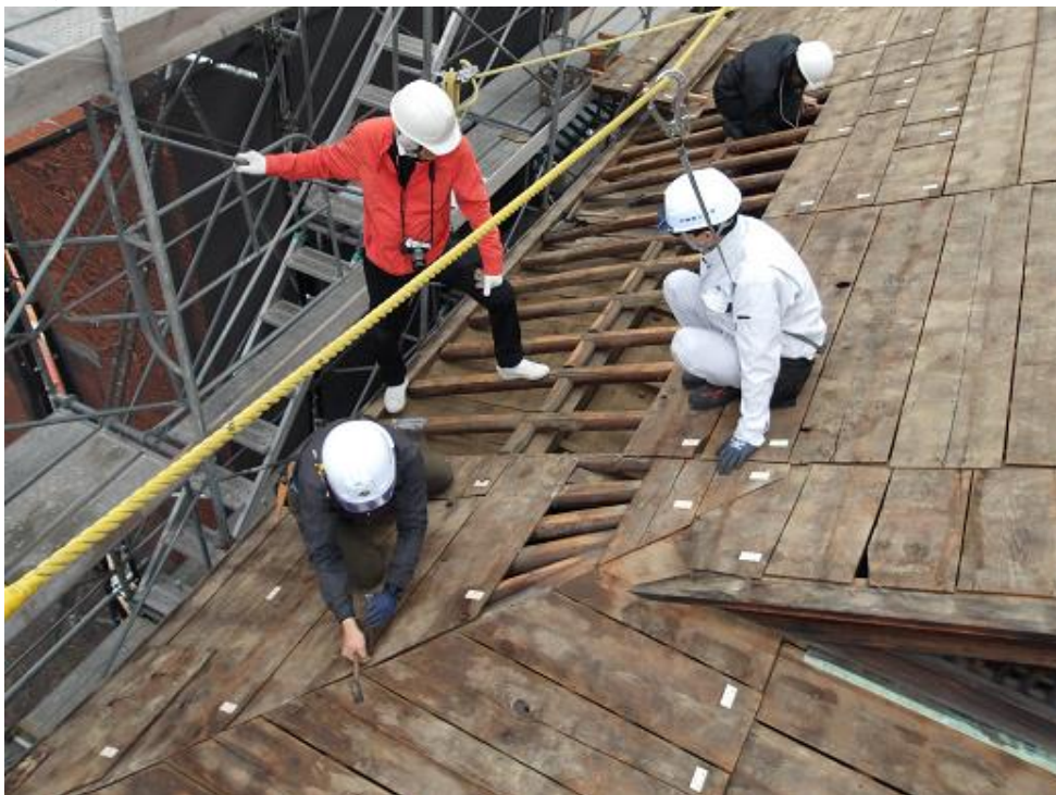
屋根部野地板除去及び調査状況①
