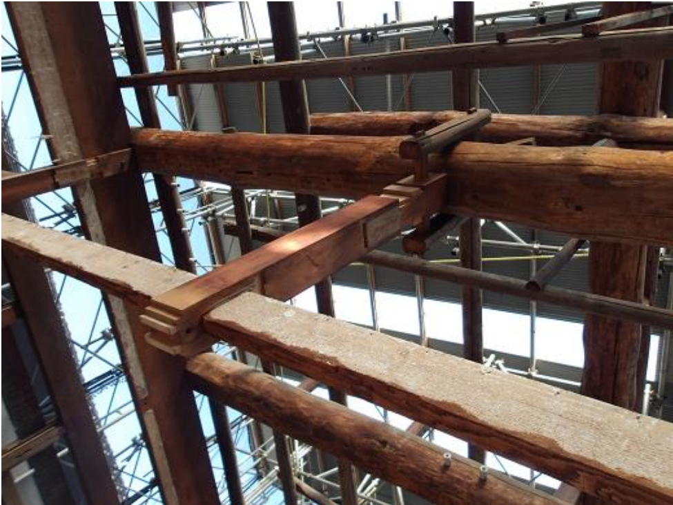
建屋解体状況
