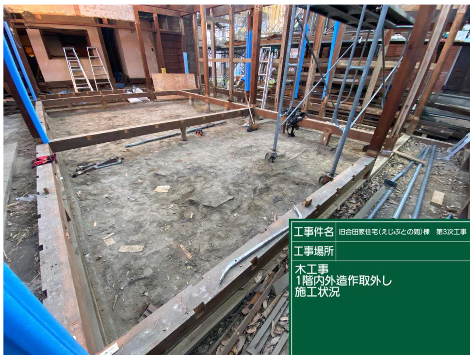
部材(内外造作)の取り外し作業
