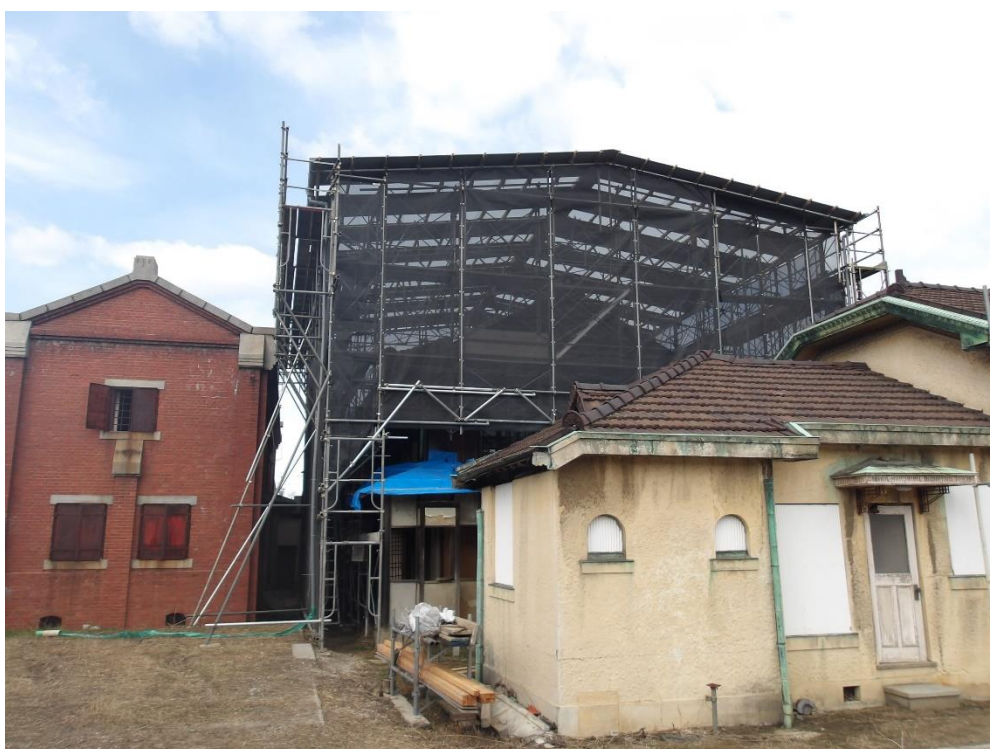
(写真 4 - 2) 足場架構完了後
