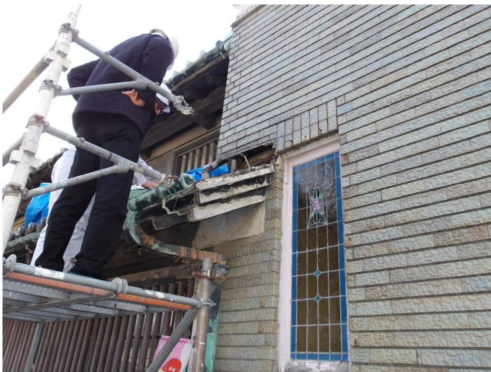
(写真 2 - 1) 店棟の屋根底部瓦除去作業
