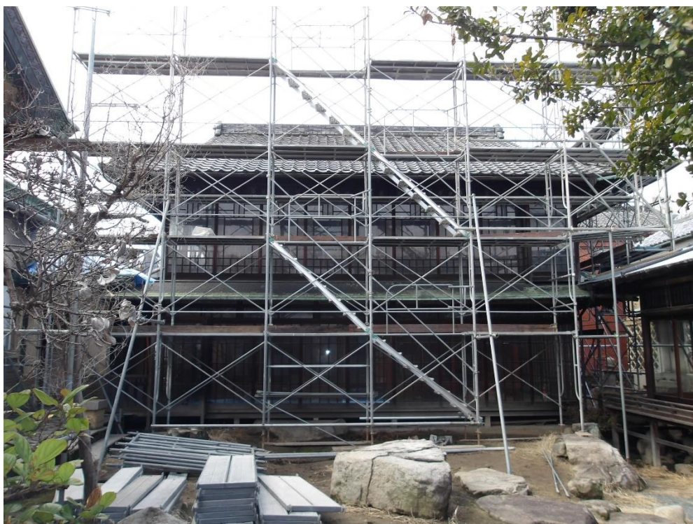
(写真 4 - 1) 足場架構工事状況
