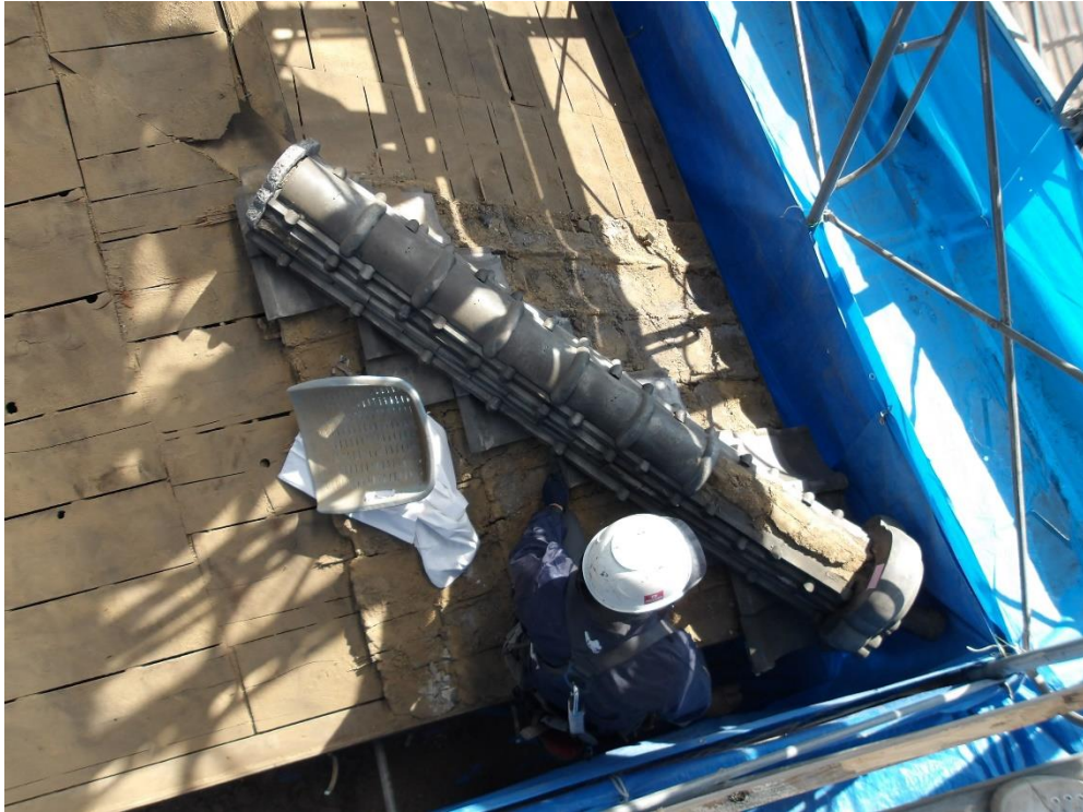
(写真 4 - 3) 瓦除去作業①
