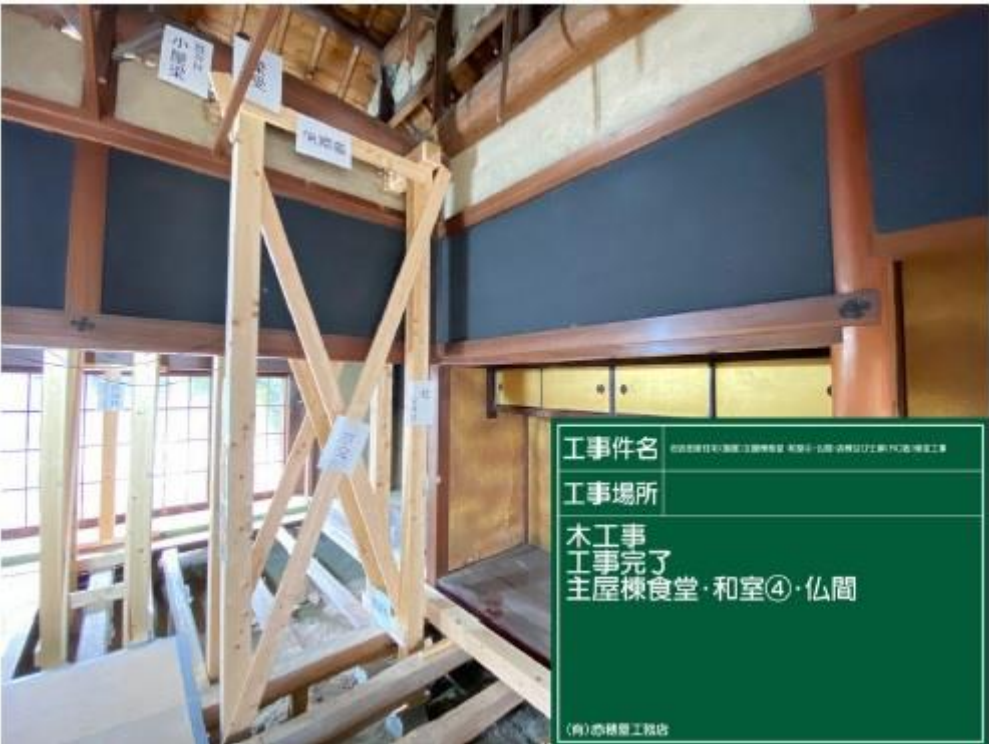
(写真1－2) 主屋和室・仏間支持材設置状況
