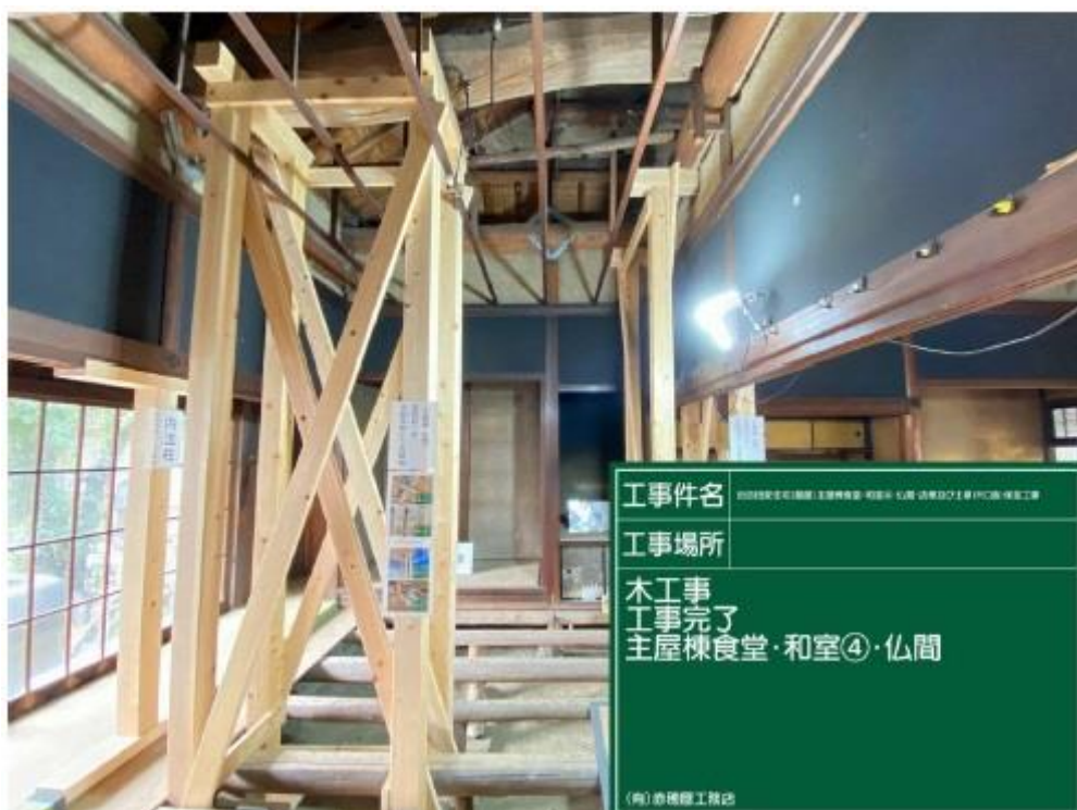
（写真 1 － 3）主屋仏間支持材設置状況①
