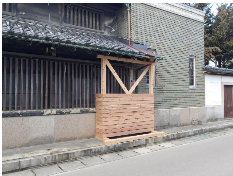
(写真 2 - 4) 店棟の屋根底部支持材設置及び屋根部銅板設置完了状況
