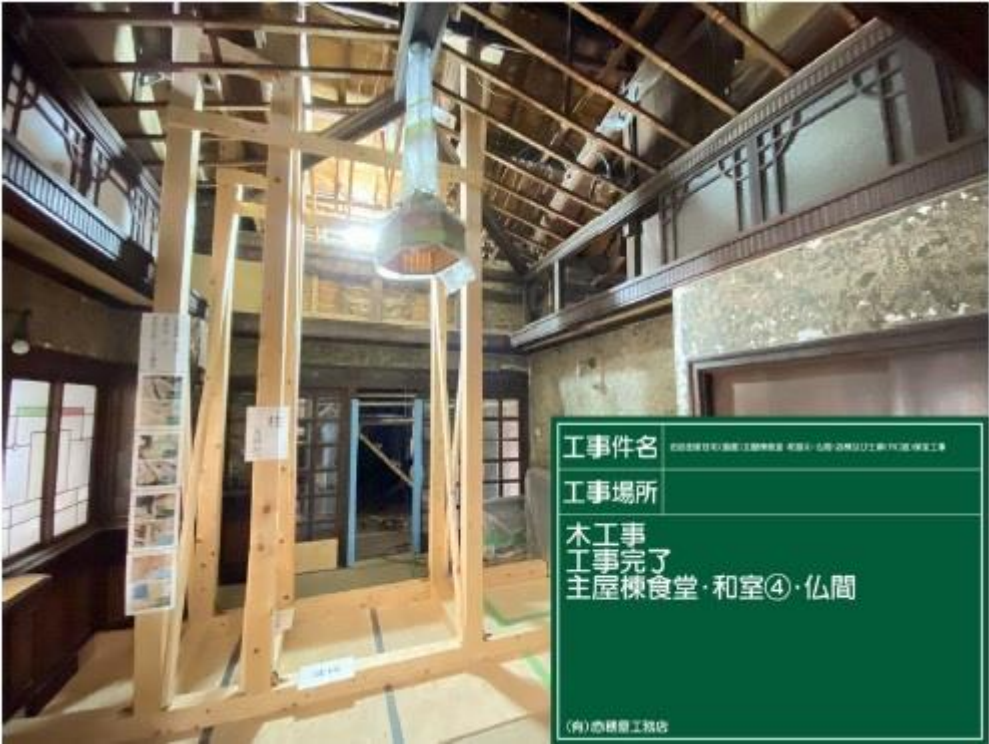
(写真1－1) 主屋食堂支持材設置状況
