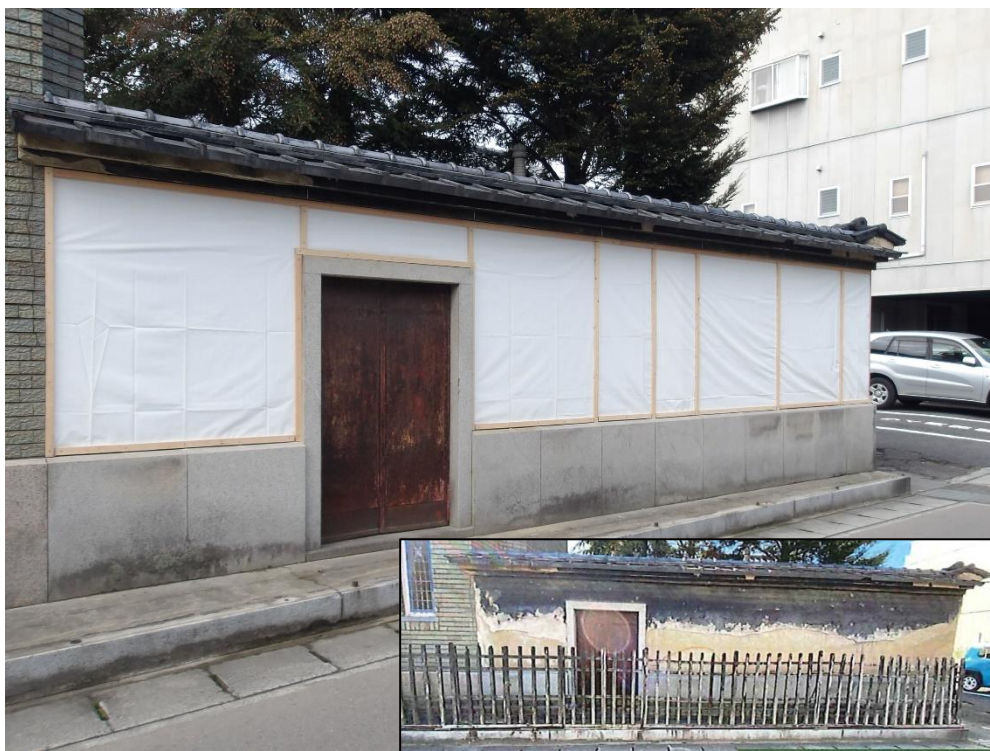
(写真 3－3) 防水シート設置状況①及び木柵撤去後（木柵撤去前：右下）
