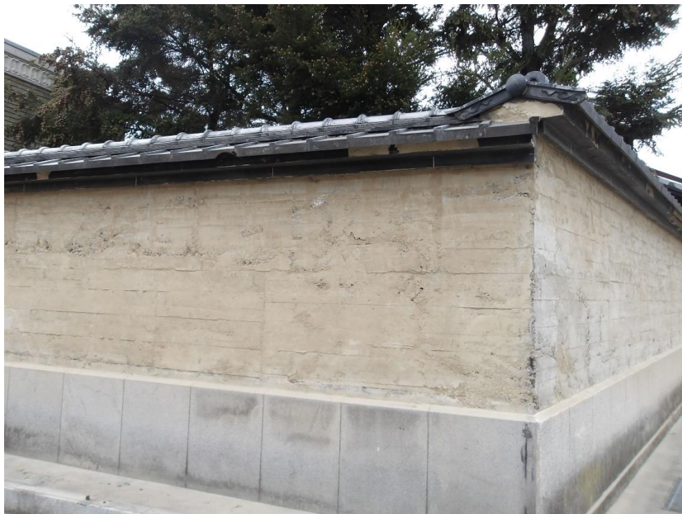
(写真 3 - 1) 土塀部黒漆喰除去状況
