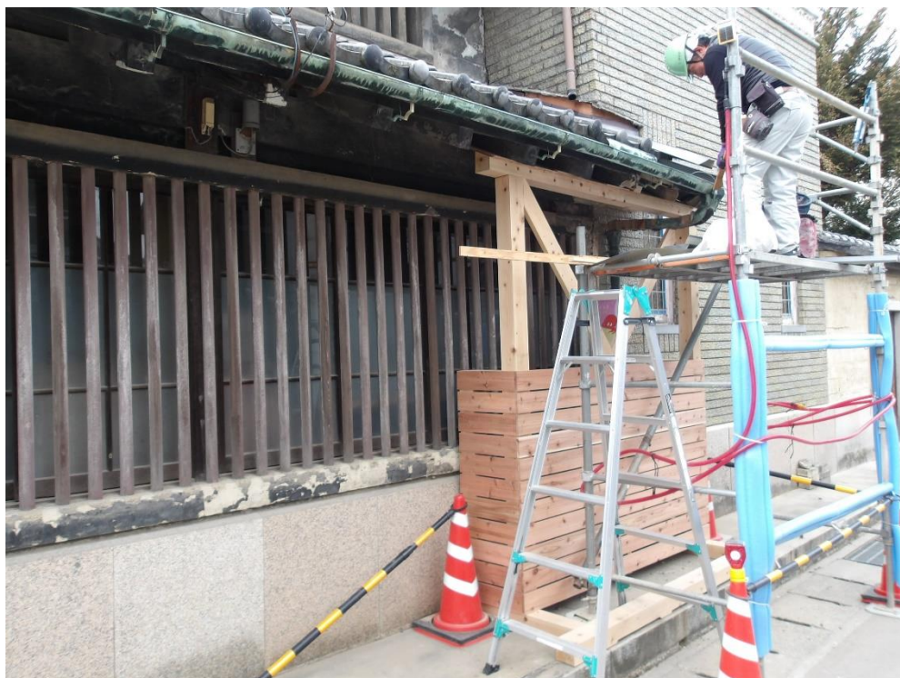
(写真 2 - 3) 店棟の屋根底部支持材設置及び屋根部銅板設置作業
