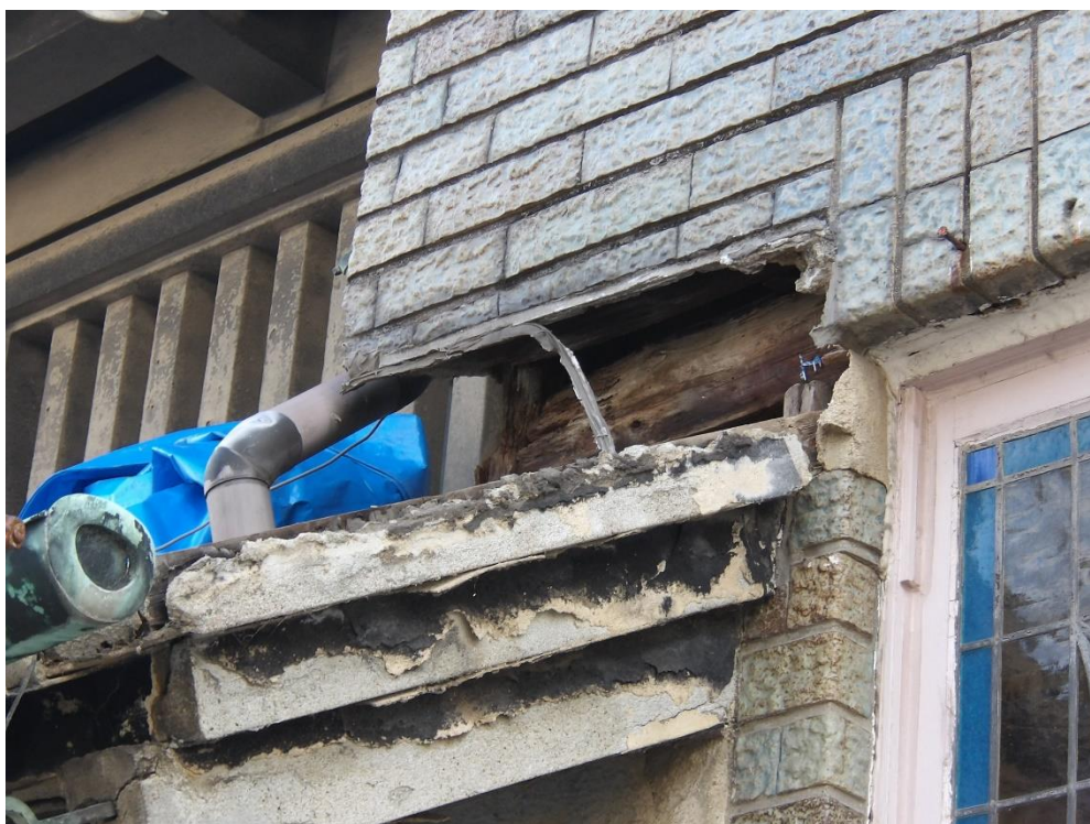
(写真 2 - 2) 店棟の屋根底部瓦除去後
