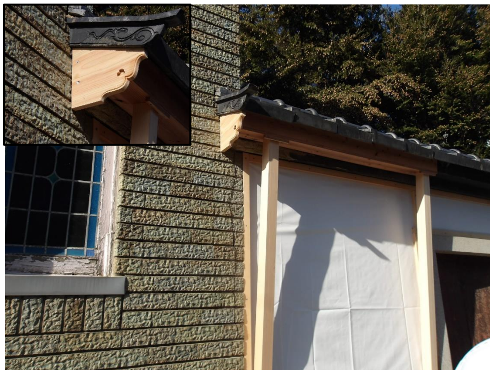
(写真 3 - 2) 土塀底部支持材設置状況
