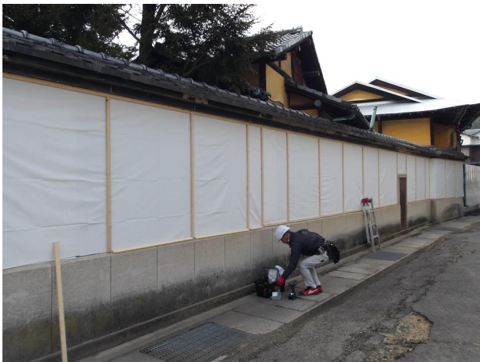
(写真 3－4) 防水シート設置状況②
