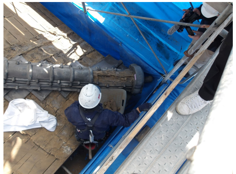
②瓦除去作業2
