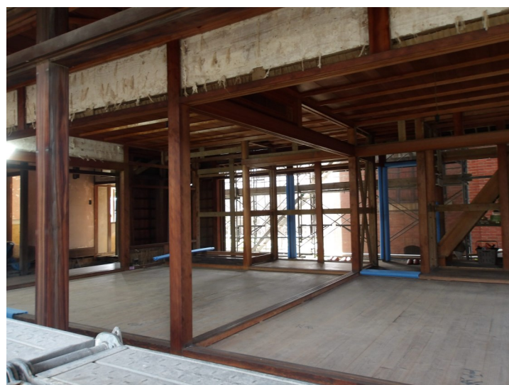
西側土塀除去後（1階部分）
