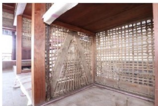
土壁除去後(2階部分)
