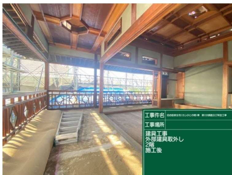
建具及び畳取り外し後(2階部分)
