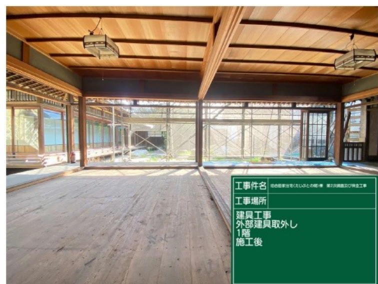
建具及び畳取り外し後(1階部分)
