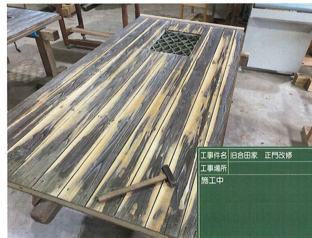
門扉の改修作業風景
