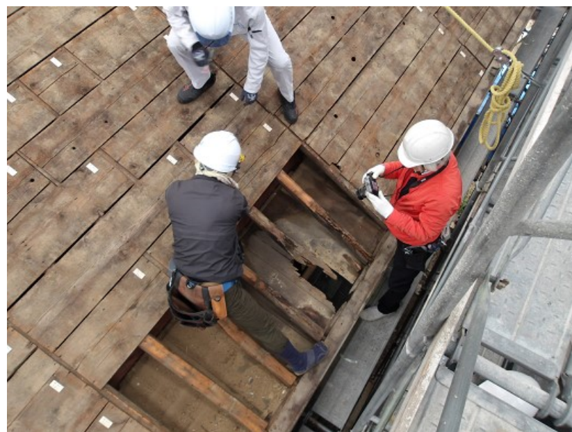
② 野地板取り外し
