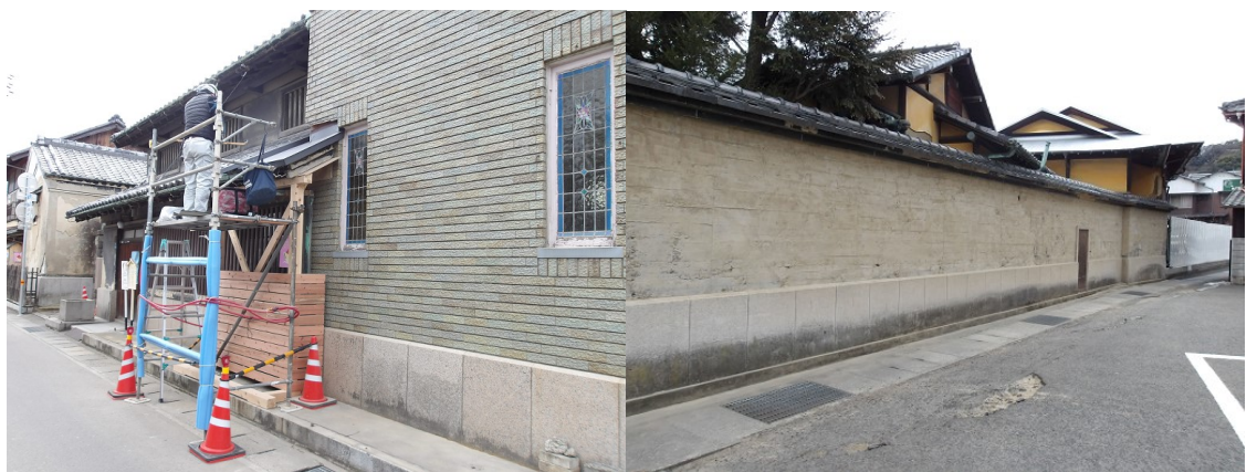
②支持材を設置し、瓦除去後の板金作業
