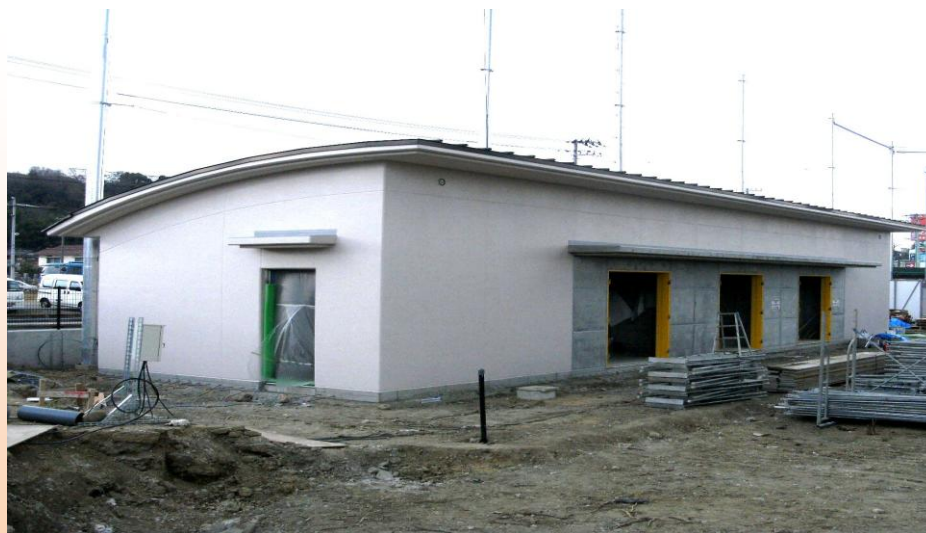
平成 28 年 1 月初旬 屋外倉庫トイレ棟の状況
