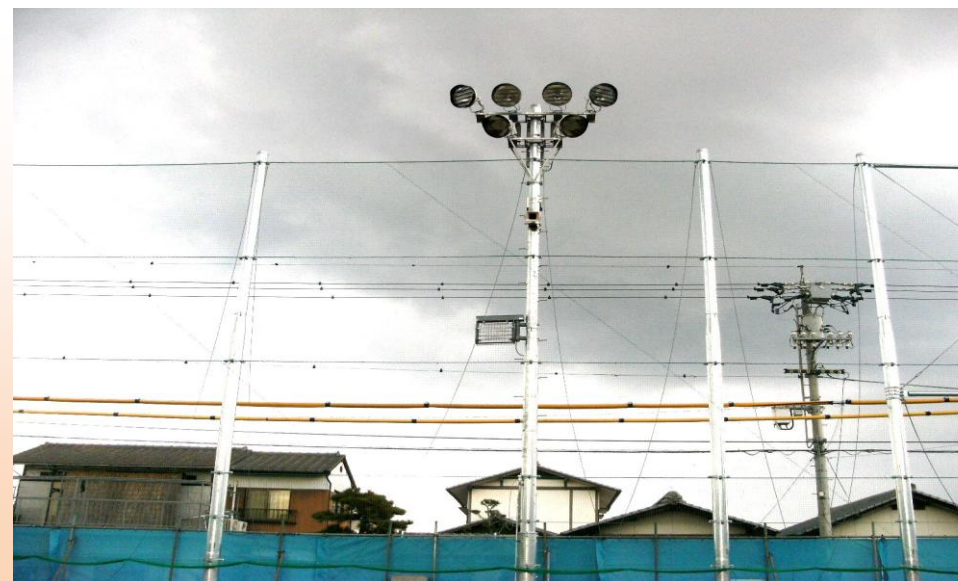
平成28年1月初旬 グラウンド照明の状況
