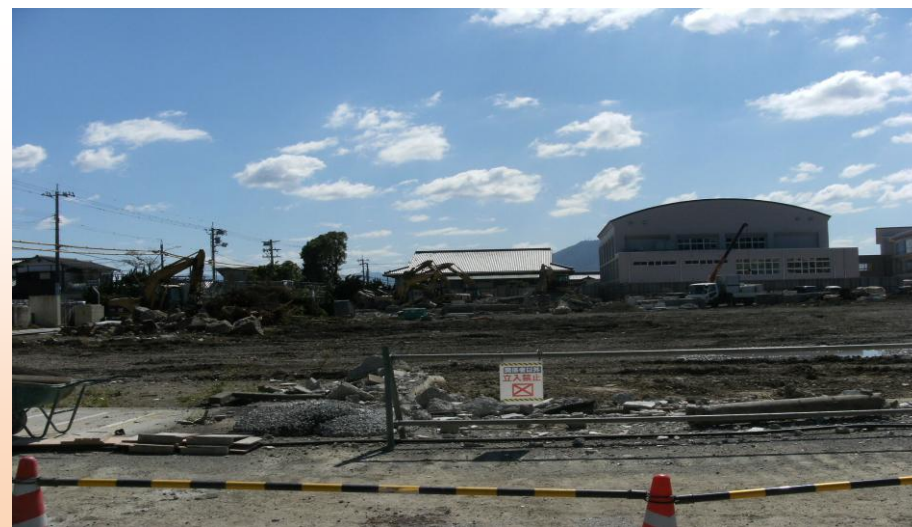
平成 27 年 10 月初旬 解体現場の状況（北→南へ撮影）
