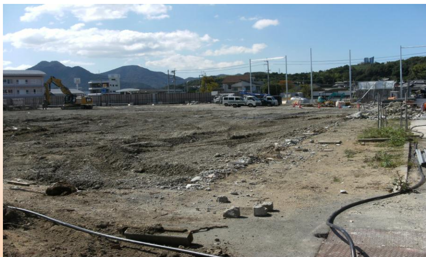
平成 27 年 10 月初旬 解体現場の状況（北東→南西へ撮影）
