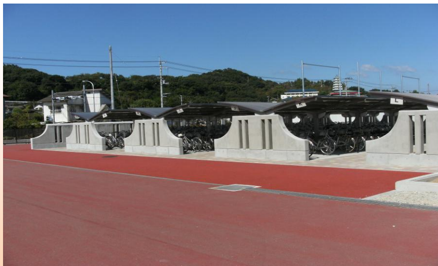
平成 27 年 10 月初旬 新駐輪場の状況（南東→北西へ撮影）
