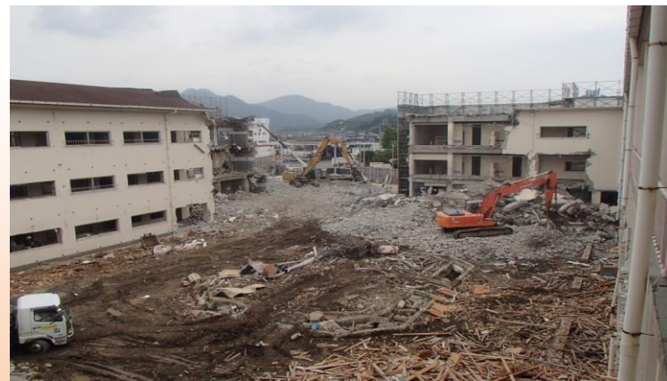
H27.7月時点 解体現場の状況（北東→南西へ撮影）
