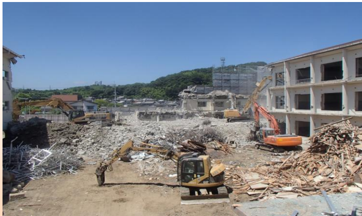
H27.7月時点 解体現場の状況（東→西へ撮影）
