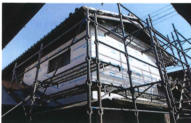
透湿シート設置
